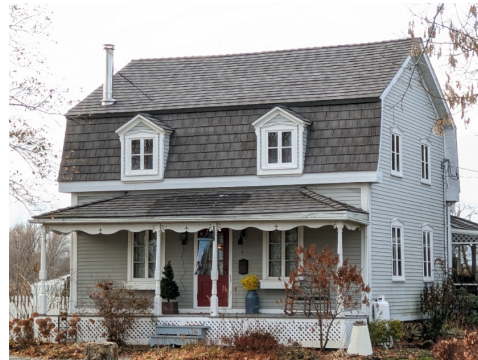
Toiture mansardée, bardeaux de bois
