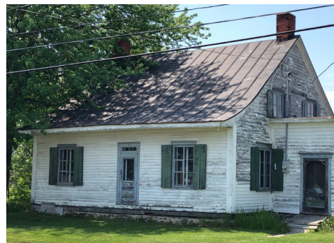
Toiture à deux versants courbés, tôle pincée
