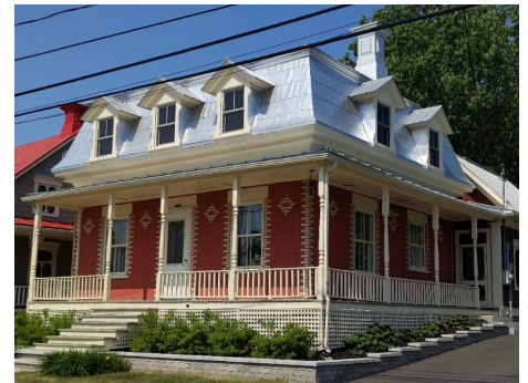
Toiture fausse mansarde, tôle en plaque
