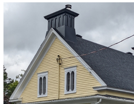
Cheminée habillée et retour de corniche
